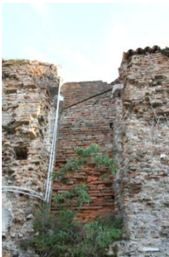
Foto 63. Particolare di una finestra murata, 2012
