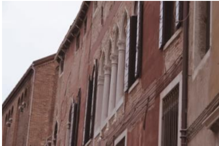
Foto 32. Quadrifora del palazzo gotico. Fondamenta Canal, 2012
