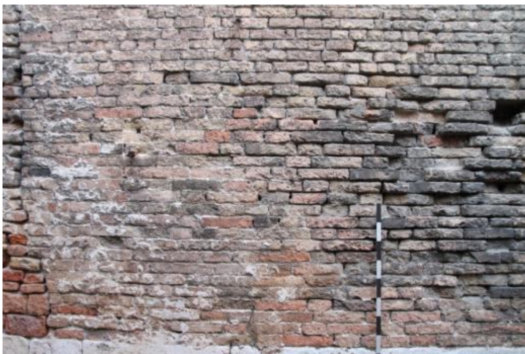
Foto 62. Muratura in laterizio, 2012
