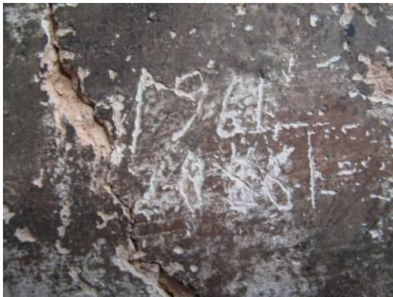
Foto 56. Dettaglio del degrado, 2012
